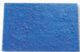
Piedra erosionada / 585 x 390 mm
